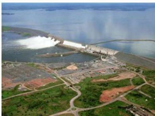
A Usina Hidrelétrica de Tucuruí foi inaugurada em 1984 (Foto: Divulgação)
