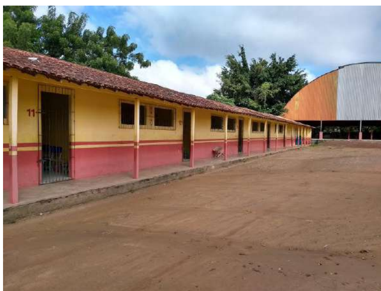
Figura 13: Salas de aula (vista externa)
